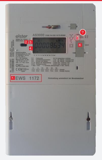
Info: Das rote LED-Lämpchen blinkt nach jeder verbrauchten Wattstunde auf. Leuchtet das Lämpchen konstant, wird in diesem Moment kein Strom verbraucht.
