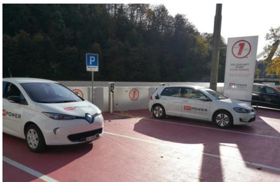
Für die eigene Fahrzeugflotte wurden am Standort Mühlenstrasse insgesamt vier neue Ladestationen für Betriebsfahrzeuge installiert. Die Infrastruktur ist mit einem intelligenten Lademanagementsystem ausgestattet. Hierbei wird die maximale Gesamtladeleistung gleichmässig auf die einzelnen Ladepunkte verteilt. Sollte die Leistung überschritten werden, wird die Ladeleistung automatisch an allen aktiven Ladepunkten reduziert.
