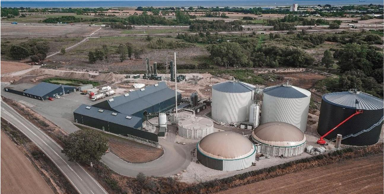
Die Biogasanlage produziert Biogas aus Abfällen der Lebensmittelindustrie, Gülle sowie Meeresalgen. Das Biogas wird aufbereitet und in das europäische Netz eingespeist.
