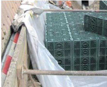
Links: Schematische Darstellung einer Rigole mit Notüberlauf (orange). Rechts: Beispielhafter Aufbau einer Rigolenversickerung.
