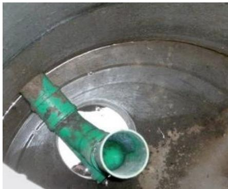
Links: Schematische Darstellung eines Retentionsschachtes mit Notüberlauf (orange). Bei Retentionsschächten dient das Volumen im Schacht als Einstauspeicher. Rechts: Abflussdrossel mit Notüberlauf.
