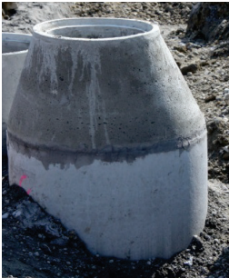
Schacht aus Betonfertigteilen Quelle: AVA
