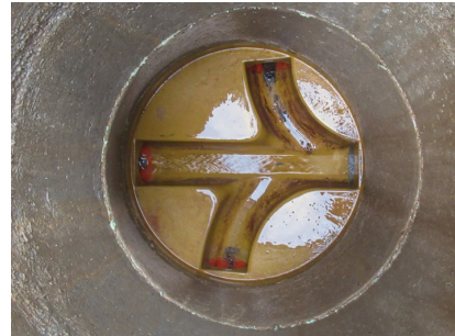
Schachtunterteil als Fertigteil Quelle: AVA
