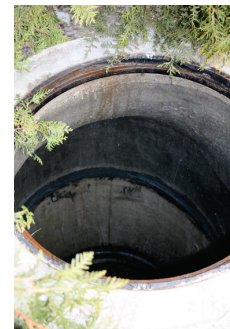
Schachterhöhung mit Versetzung des Schachtkonusses
