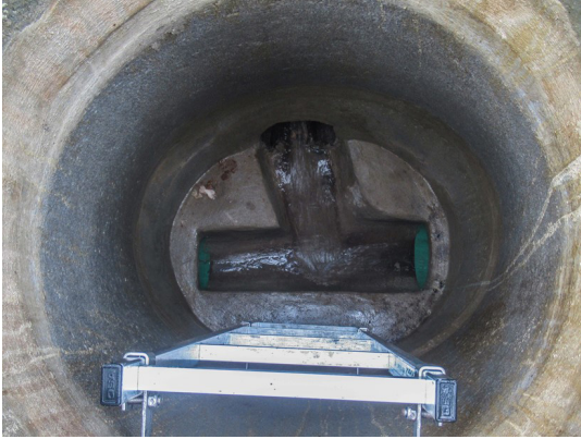
Seitlicher, ins Bankett eingeführter Anschluss. Quelle: AVA
