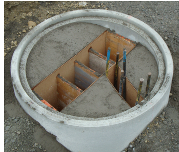
Schachtsohle manuell gefertigt Quelle: AVA
